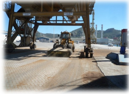
Barrido de la zona de carga de camiones
