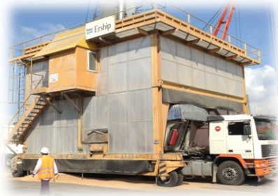
Tolva semi ecológica cubierta con policarbonato para reducir las emisiones durante la carga de camiones
